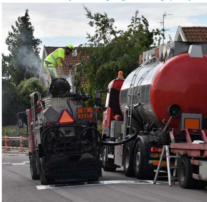
Overfladebelægningen blev lagt på vejene i starten af august – der var gang i det tunge grej!
